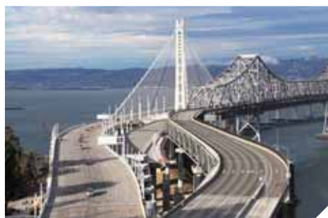
世界抗震等级最高的美国旧金山新海湾大桥
