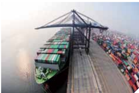
深圳港盐田港区集装箱码头扩建工程
