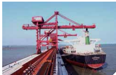
青岛港董家口港区30万吨(兼顾40万吨) 世界最大矿石接卸码头
