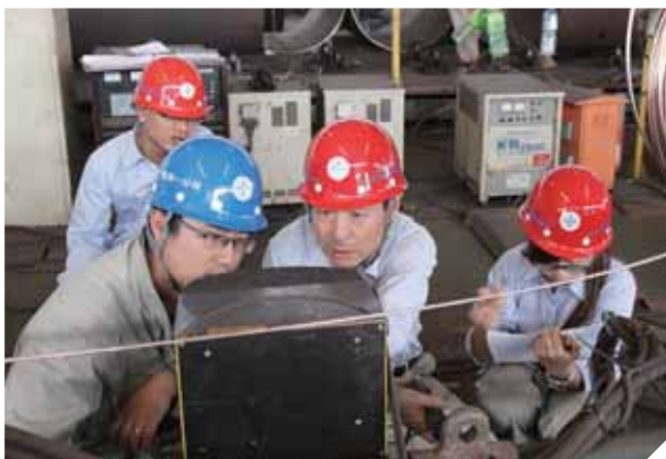
检查巴布亚新几内亚莱城港潮汐码头一期工程钢桩焊接质量
