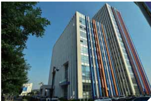
大连香炉礁物流中心Ⅱ区——商贸物流大厦项目
