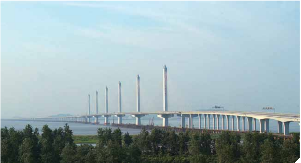
浙江嘉绍跨江公路大桥
