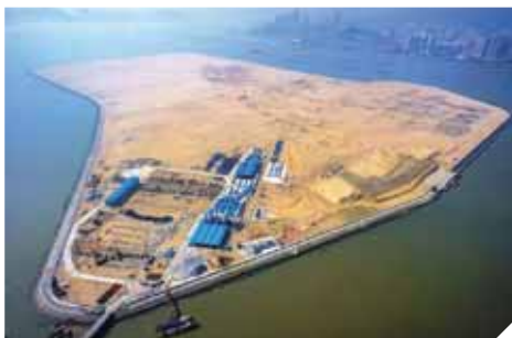
建设中的港珠澳大桥珠澳口岸人工岛
