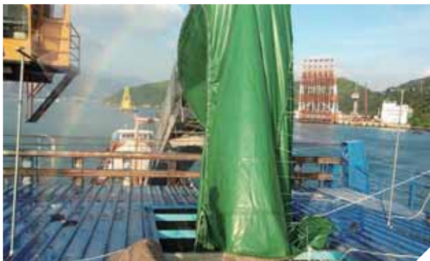
港珠澳大桥建设中，用保护膜对材料运输和卸载全程封闭，避免粉尘污染
