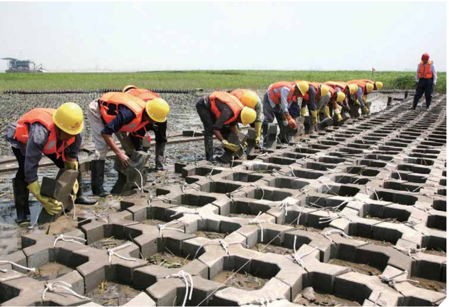
在长江航道高滩区铺设生态排和土工格栅，种植芦苇恢复生态
