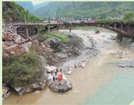
抢修因地震受损桥梁
