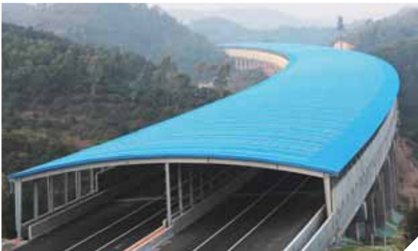
在高速公路搭建顶棚钢结构，防止雨水冲刷路面污染附近生活用水水库
