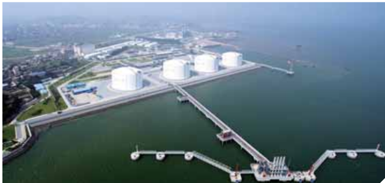
福建LNG(液化天然气) 站线项目港口工程
